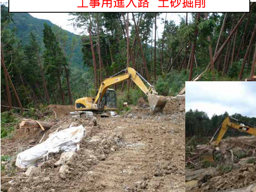
工事用進入路 土砂掘削
