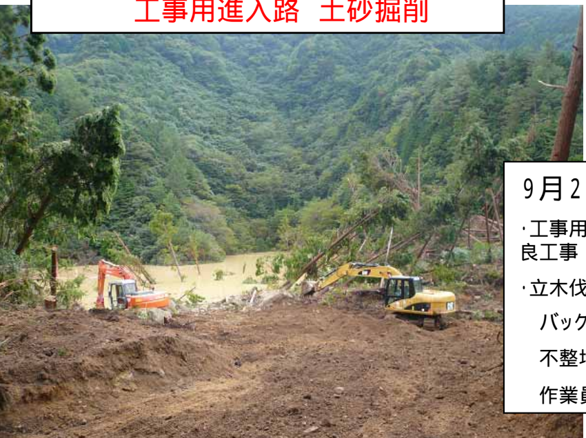
工事用進入路 土砂掘削
