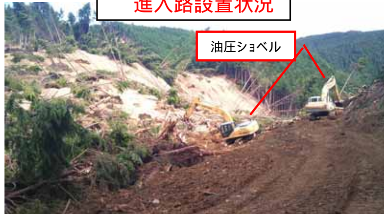
進入路設置状況
