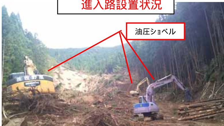
進入路設置状況
