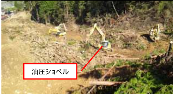
進入路倒木除去・切断・集積状況
