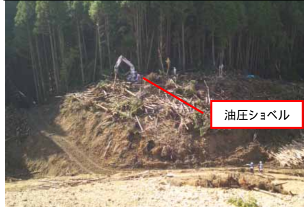
進入路倒木除去・切断・集積状況
