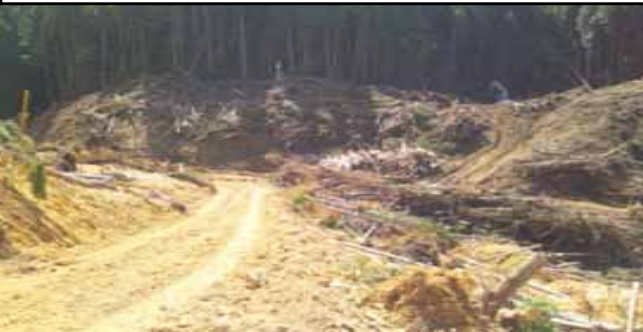
進入路倒木除去・切断・集積状況
