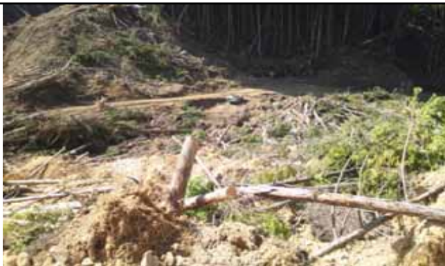
進入路倒木除去・切断・集積状況
