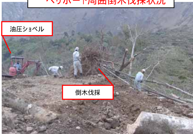
ヘリポート周囲倒木伐採状況
