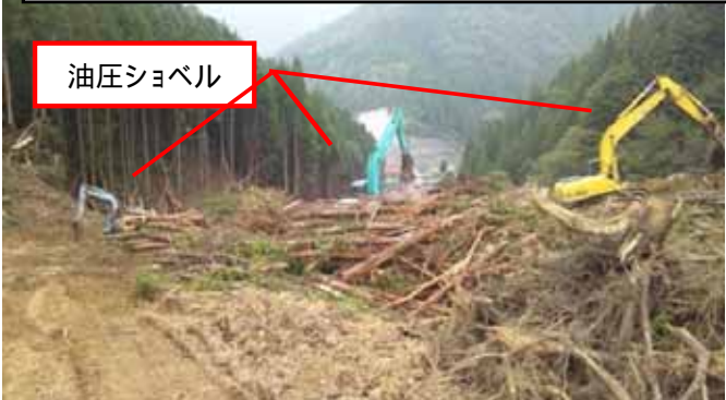
進入路倒木除去・切断・集積状況
