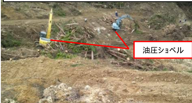
進入路倒木除去・切断・集積状況
