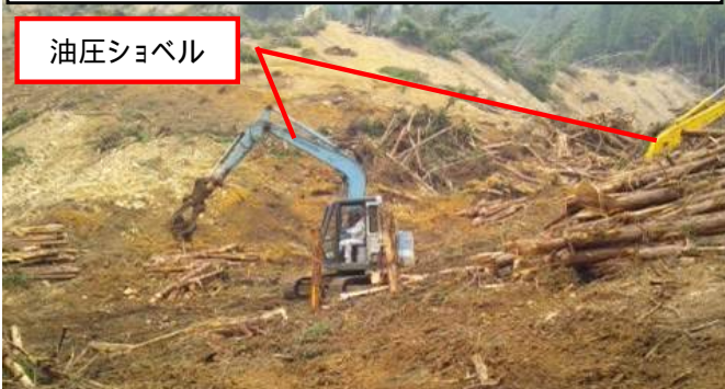
進入路倒木除去・切断・集積状況
