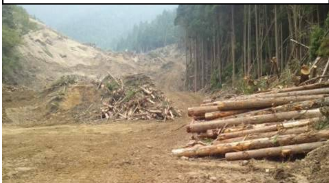
進入路倒木除去・切断・集積状況
