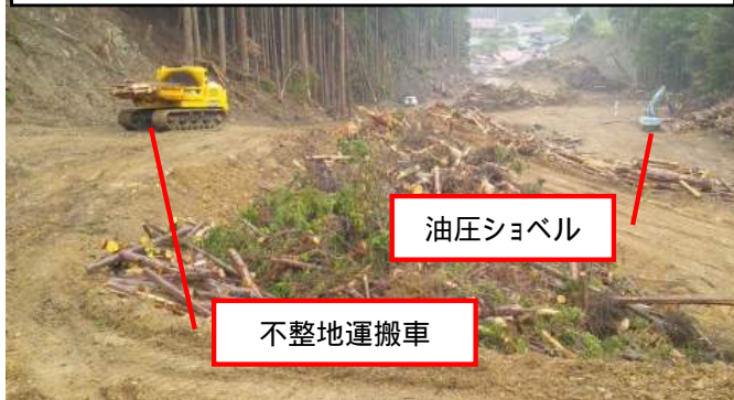
進入路倒木除去・切断・集積状況
