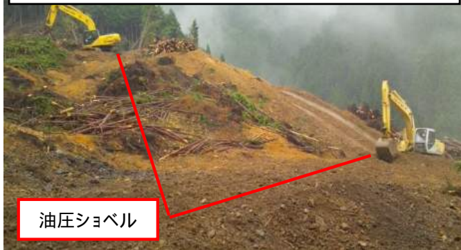
進入路倒木除去・切断・集積状況
