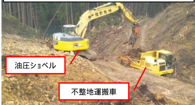
進入路倒木除去・切断・集積状況
