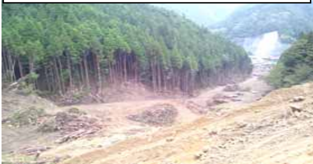
進入路倒木除去・切断・集積全景
