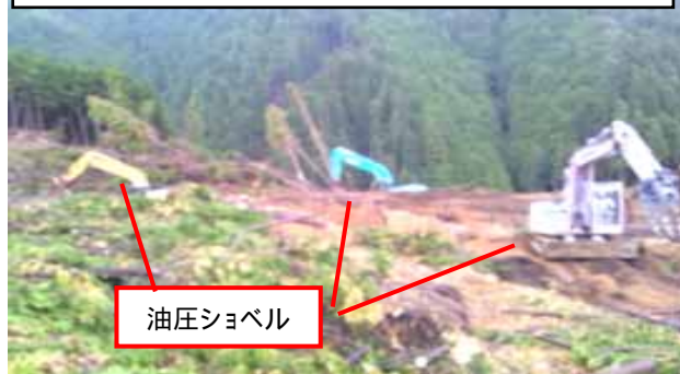
進入路倒木除去・切断・集積状況
