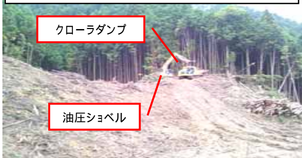
進入路倒木除去・切断・集積状況
