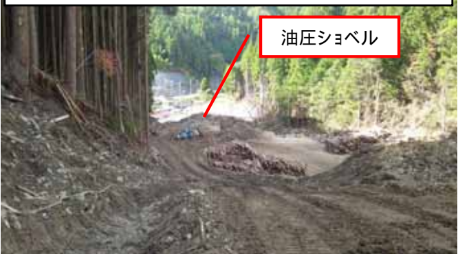
進入路倒木除去・切断・集積状況
