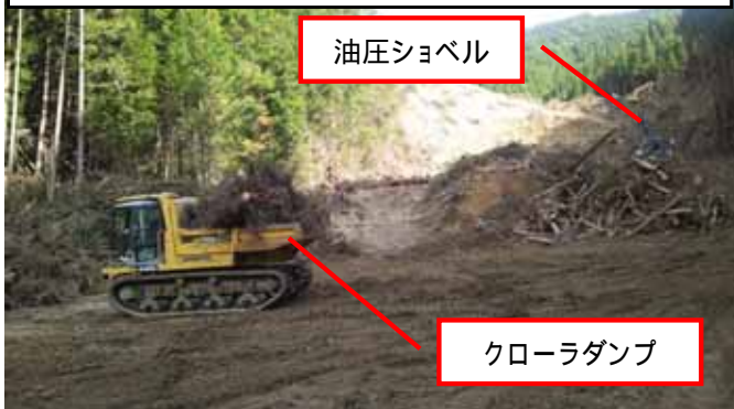
進入路倒木除去・切断・集積状況
