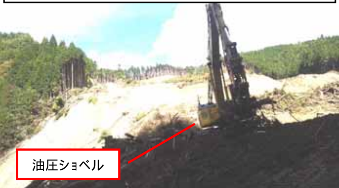
進入路倒木除去・切断・集積状況
