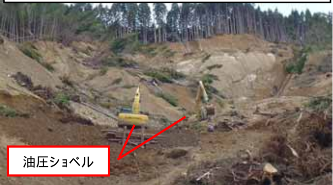
進入路倒木除去・切断・集積状況
