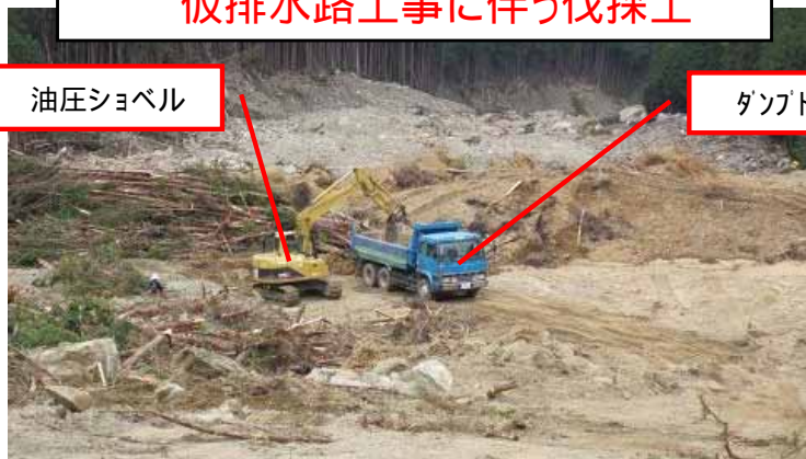
仮排水路工事状況
