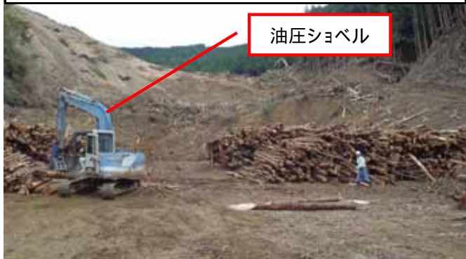
進入路倒木除去・切断・集積状況
