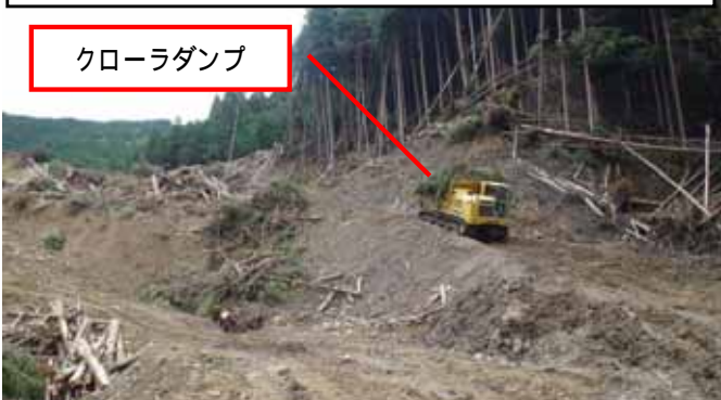
進入路倒木除去・切断・集積状況
