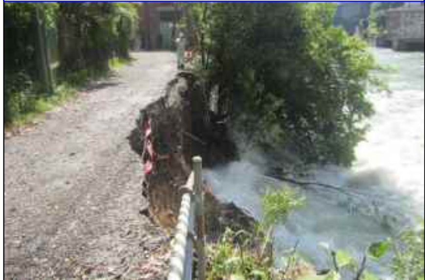
トンネル式放流設備からの放流による打上げ状況 (5月9日8時45分頃撮影 約600m 3 /s)
