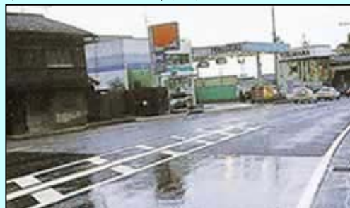
〔国道1号大津市逢坂1丁目〕
