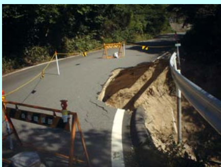
〔国道421号石樽峠(平成16年10月)〕
