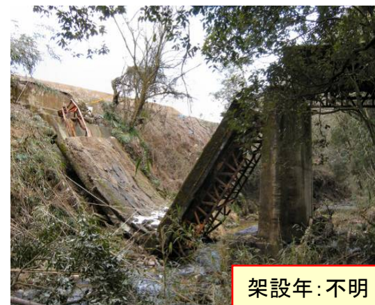
香川県と徳島県の県境(管理者不明) 2007年11月(橋梁の崩落)
