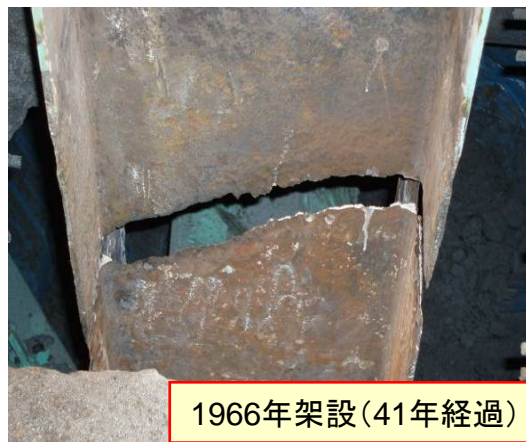
本荘大橋 2007年8月 (トラス橋の斜材の破断)
