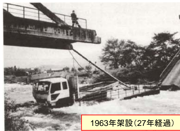
岐阜県福田町町道 島田橋 1990年 (腐食によるPCケーブルの破断)
