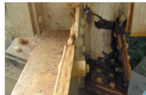
支柱の座屈(国道1号白川橋)
