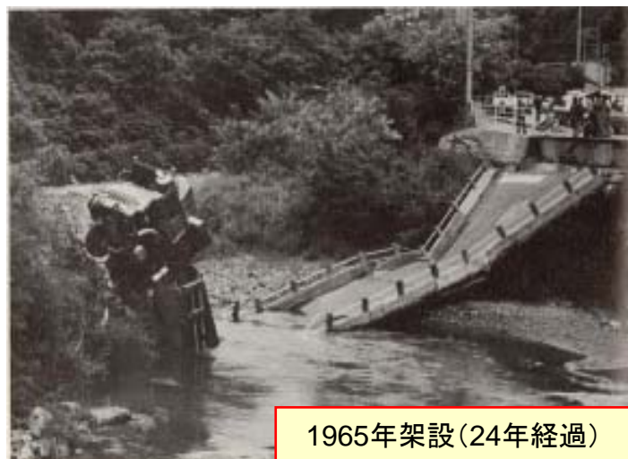
長野県木祖村村道 新菅橋 1989年 (腐食によるPC鋼線の破断)
