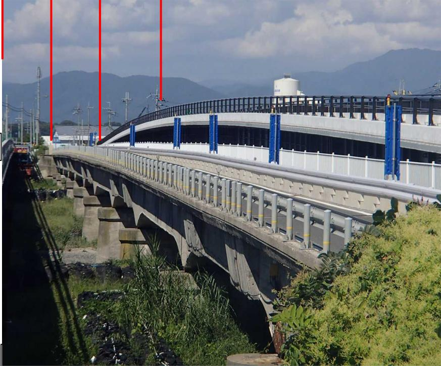
昭和 29 年に架設されたゲルバーR C T 桁橋（写真中央）が 59 年の役割を終えて、平成 25 年 10 月 15 日から新たに架けられた姉川橋（写真右上）に役割を引き継ぎます。完成したのは彦根向き車線です。
