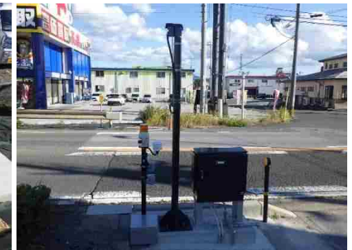
車両検知器、気象センサー、散布ノズル部設置状況
