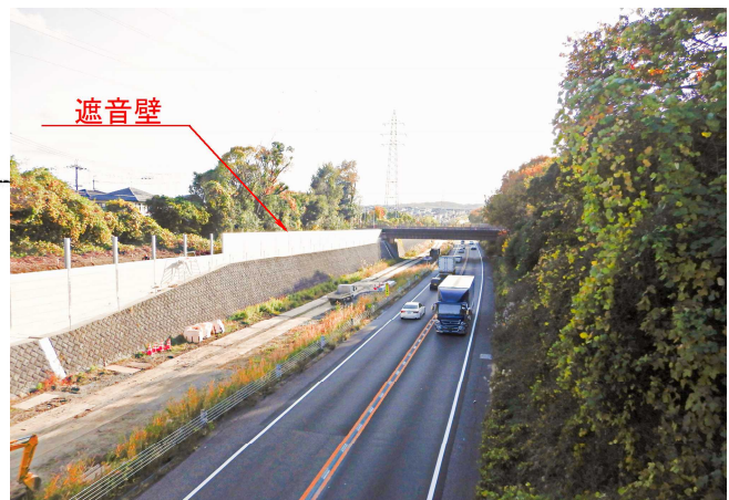
工事中の状況
