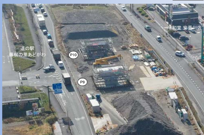
橋脚工事 上り線(京都方面)の橋脚工事(P9、P10橋脚)を行っています。
