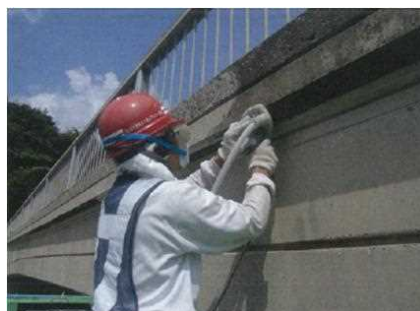
補修実施状況
