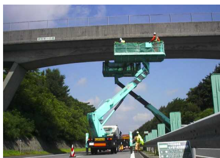
点検実施状況
