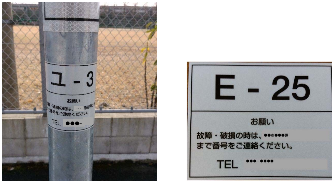
図-解 4-2 利用者から通報を受けやすく工夫している事例
