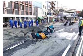
埋設管の老朽化に伴う道路陥没
