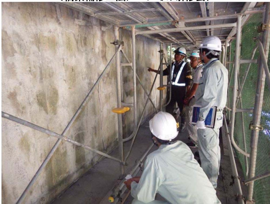
＜橋梁補修工法についての研修会＞
