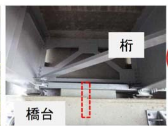
写真-5 アンカーバーのイメージ
