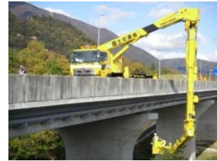
橋梁点検車による点検
