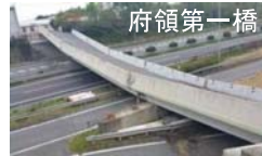
府領第一橋 ロッキング橋脚を有する橋の落橋
