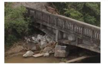
写真-2 平田・小柳線 田中橋
