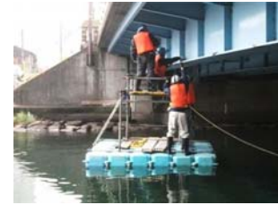
船(フロート)による点検
