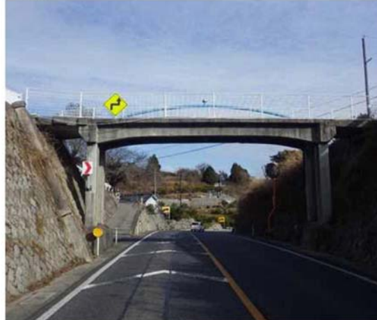
地方管理の跨道橋(未対策)
