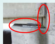
支保交換や桁端点検の空間なし
