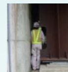
支保交換や桁端点検の空間なし
