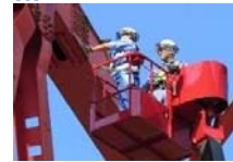
直轄診断(三島大橋)
