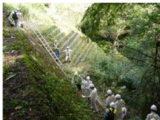
道路防災ドクターによる現地診断
