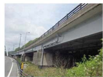
写真-4 阿蘇口大橋 (国道57号)
