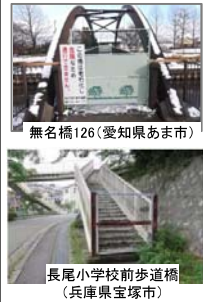
通行止め橋梁
