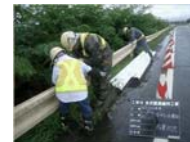
<防護柵の取替>
