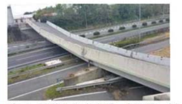
写真-1 県道小川嘉島線 府領第一橋
