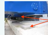
支保交換が容易な構造の例
