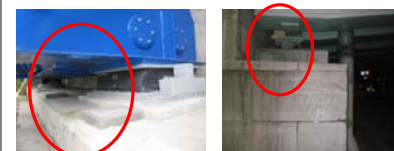
ジャッキアップに配慮した構造
