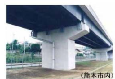
写真-3 国道3号 跨線部 (熊本市内)
