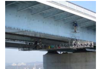
移動式吊足場による点検
