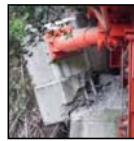
南阿蘇橋（被災前） 制震ダンパー取付部の損傷
