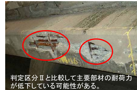
判定区分Ⅲ(主桁の断面欠損)
