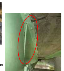
主桁の変形
