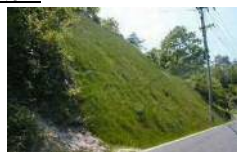
切土 (のり面保護)
