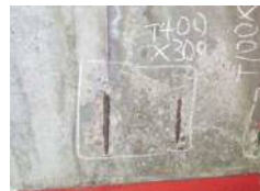
下部工にASRによる劣化が疑われる
