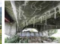
主桁のひびわれ
