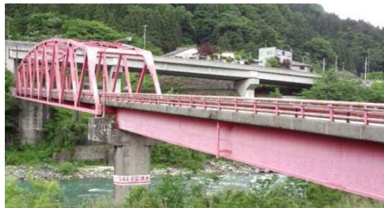
<音沢橋の状況>
