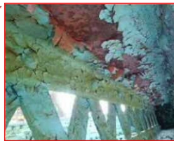
鋼材の腐食
