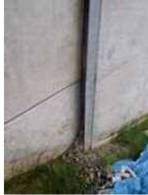
写真 土砂のこぼれ出し例
