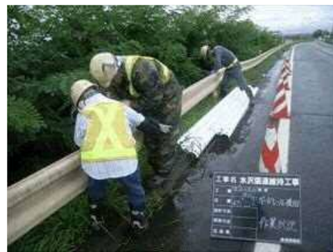
＜防護柵の取替＞
