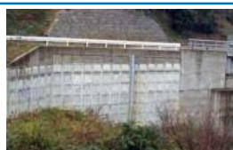
盛土 (補強土壁)
