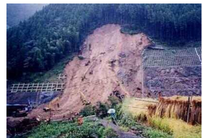
強風化・土砂化斜面での崩壊例
