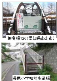
通行止め橋梁
