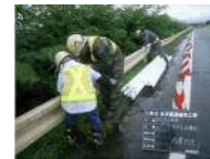
<防護柵の取替>
