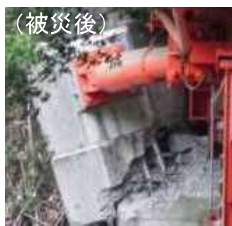
制震ダンパー取付部の損傷
