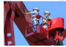
直轄診断(三島大橋)
