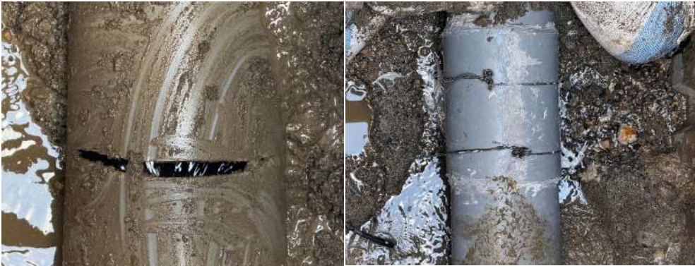
補修事例: 町道三ツ池防災道路線(滋賀県豊郷町)
