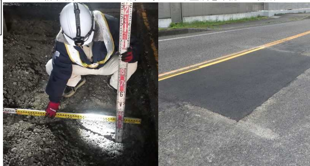
補修事例：国道8号（滋賀県蒲生郡）
