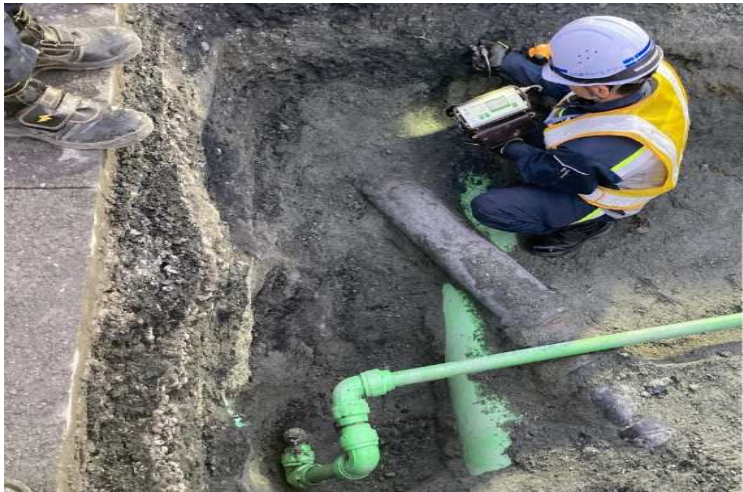
補修事例: 県道仰木本堅田線(滋賀県大津市)
