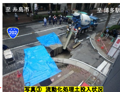
写真③ 流動化処理土投入状況
