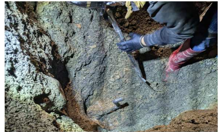
補修事例：市道旧古賀2号線（滋賀県高島市）
