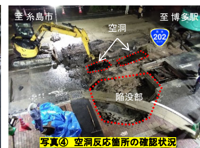
写真④ 空洞反応箇所の確認状況
