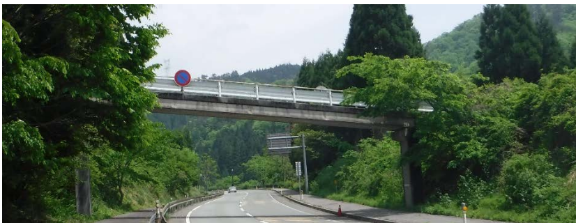
<野口跨道橋全景>
