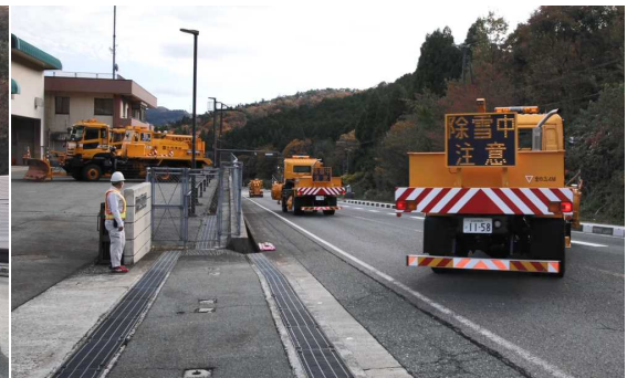
除雪機械出動
