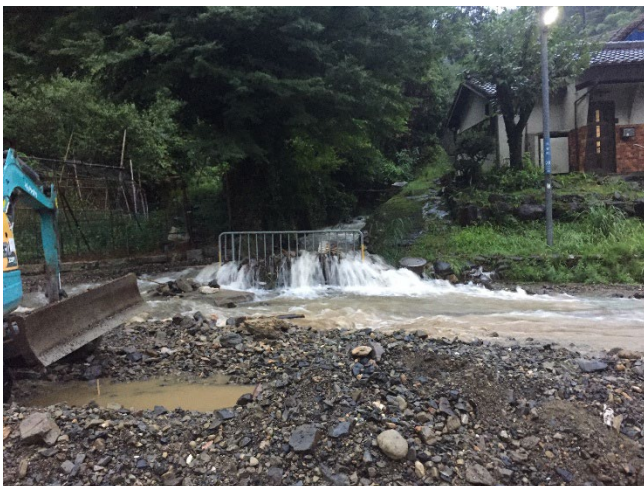
令和3年8月(国道1号 滋賀県大津市)
