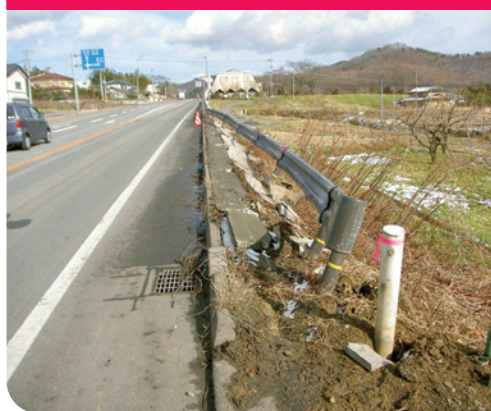
ガードレール・標識等の損傷
