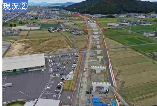
野洲市小中小路付近から野洲市小篠原方面を望む
