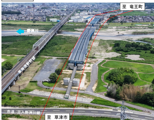
② 野洲川橋
