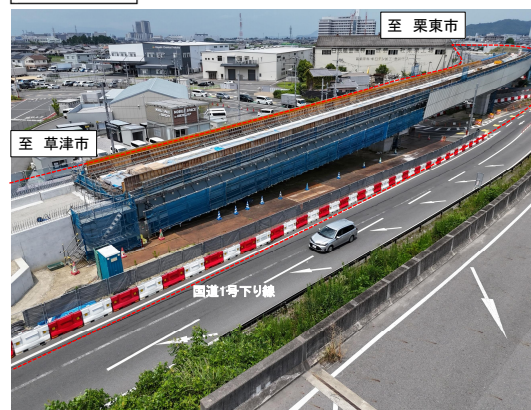
④ 手原高架橋
