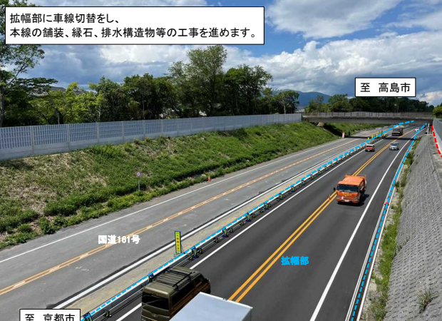
TOPICS 3 湖西道路千野地区舗装工事 R7.5月 撮影
