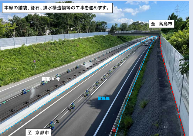
TOPICS 3 湖西道路千野地区舗装工事 R7.7月 撮影
