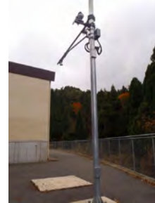
【積雪観測設備】
