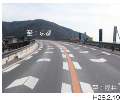
写真① 【開通区間(バイパス部)】
