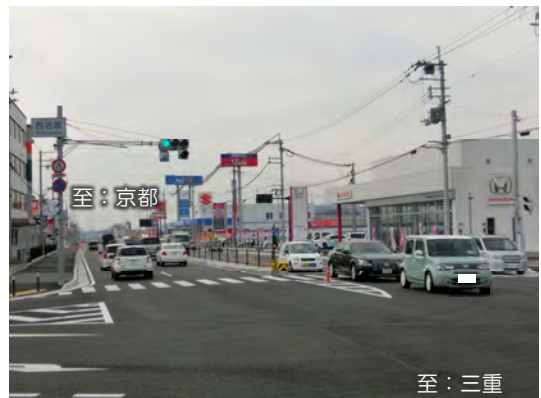
写真② 【開通区間(名坂地区)】
