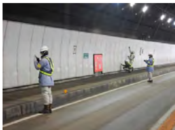
【トンネル点検】
