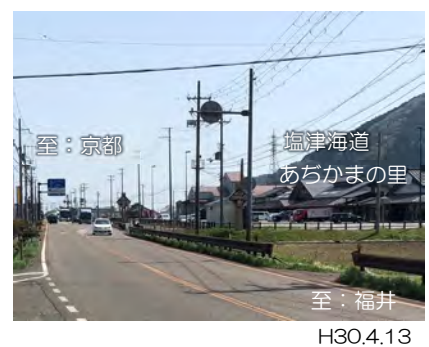
写真② 【現道拡幅部】
