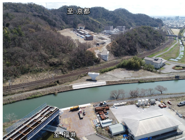
写真② 【工事区間 (米原市入江地区)】
