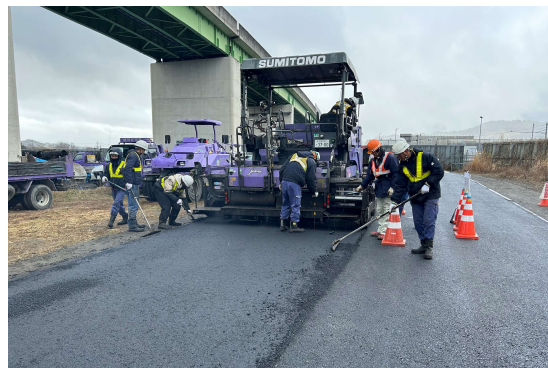
【中温化舗装の施工状況】
