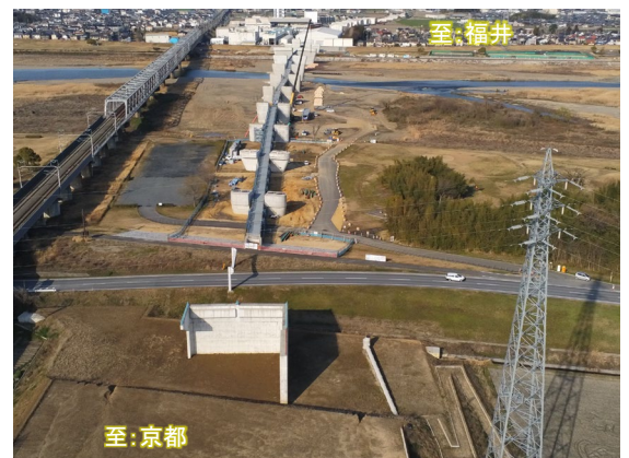
写真② 【工事区間（野洲川左岸地区）】
