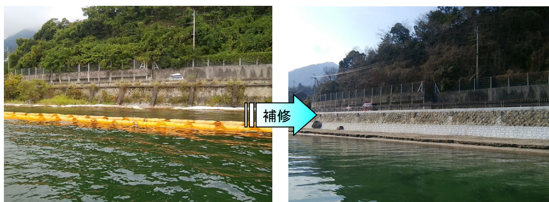
施工前 施工後 国道161号大津市北小松地区（令和5年度実施）
