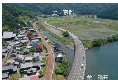
写真① 【開通区間(バイパス部)】
