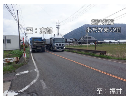
写真② 【現道拡幅部】
