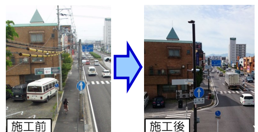
【施工事例：国道1号滋賀県草津市】
