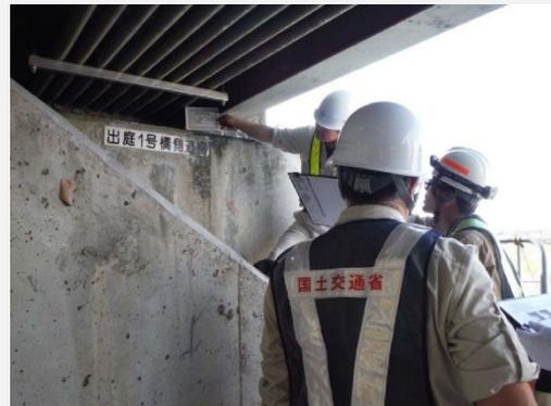
近接目視を基本とし、必要に応じて触診や打音等の非破壊検査を実施
