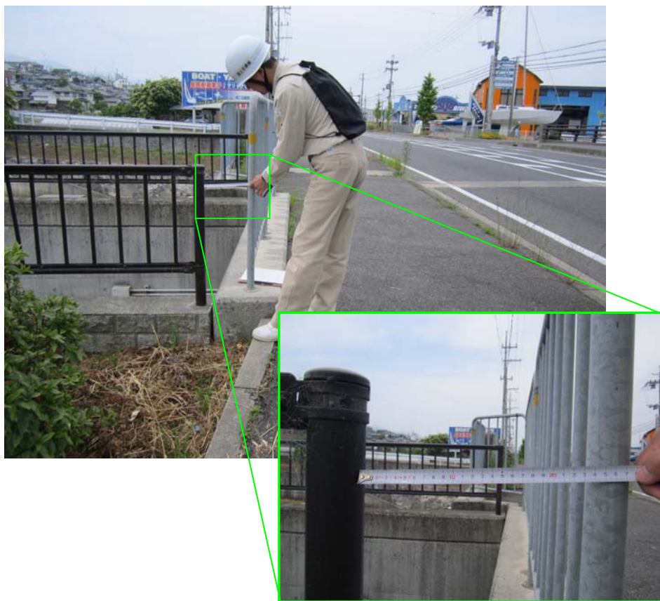
転落防止柵の設置状況
