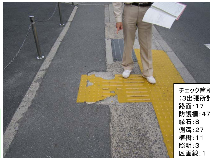
点字ブロックの破損状況
