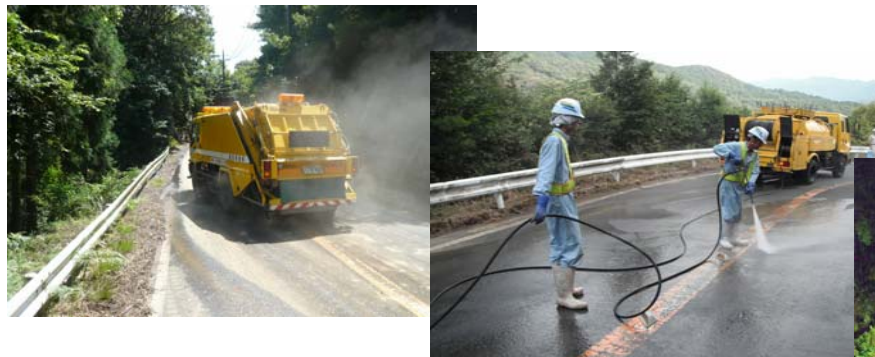
路面清掃作業
