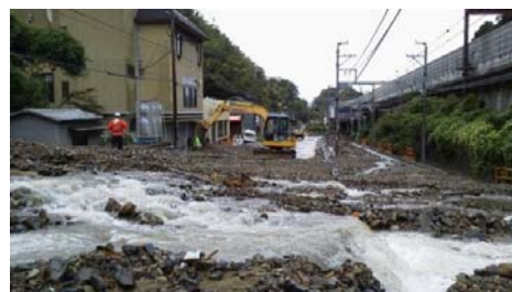
▲台風18号災害緊急応急復旧 作業状況 国道1号大津市大谷付近
