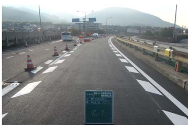
▲国道161号藤尾高架橋橋梁補修工事 施工者:(株)昭建
