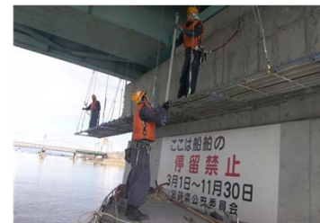
▲国道1号瀬田川大橋他橋梁補修工事 施工者:田中シビルテック(株)
