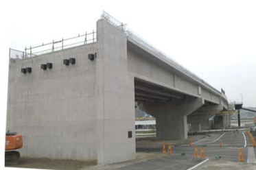
▲栗東水口道路石部南高架橋橋台他工事 施工者:(株)桑原組
