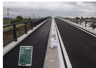
▲姉川橋舗装工事 施工者:鹿島道路(株) 関西支店
