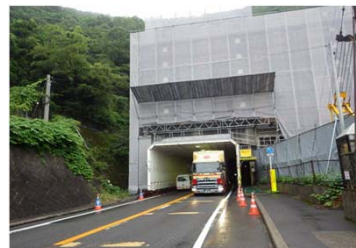
▲賤ヶ岳トンネル換気所撤去その他工事 施工者:(株)桑原組
