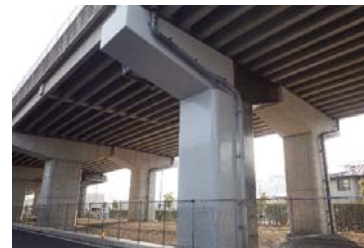
▲国道161号坂本高架橋橋梁補修工事 施工者:(株)桑原組
