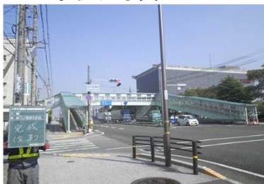
▲国道8号北新横断歩道橋他修繕工事 施工者:(株)泉建設工業
