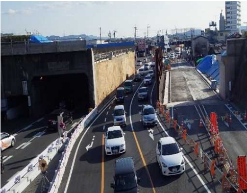
▲国道1号草津川隧道撤去他工事 施工者:(株)桑原組
