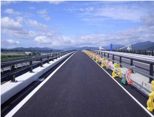
▲姉川橋舗装他工事 施工者:北川ヒューテック(株) 関西支店
