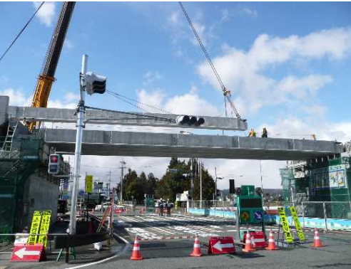
▲国道161号青柳第2高架橋PC上部工事 施工者:川田建設(株) 大阪支店
