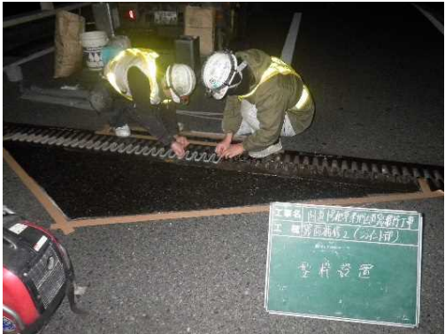
▲国道1号他草津地区道路維持工事 施工者:三国工業(株)
