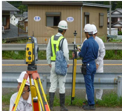
(TLS計測機器による出来形確認)
