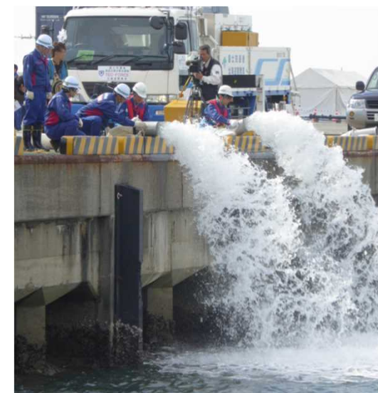
排水ポンプ車を用いた排水作業の訓練
