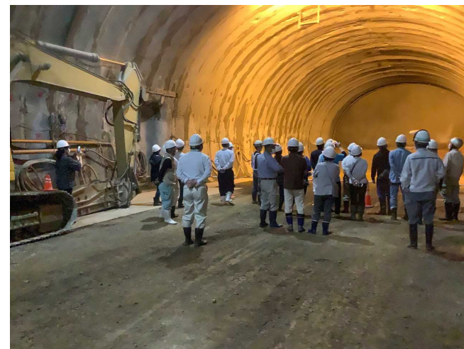
トンネル切羽付近での説明
