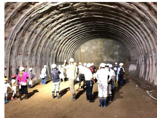
トンネル切羽付近での説明
