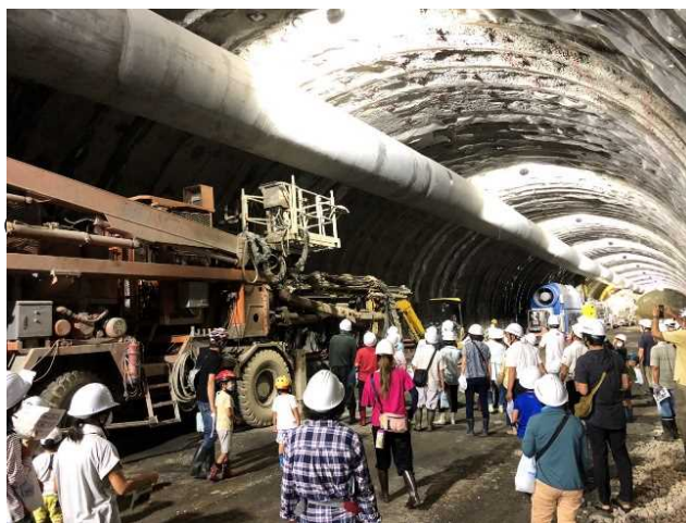
トンネル建設機械の説明
