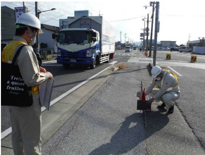
舗装や構造物が健全かを点検
