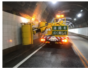
トンネル清掃
