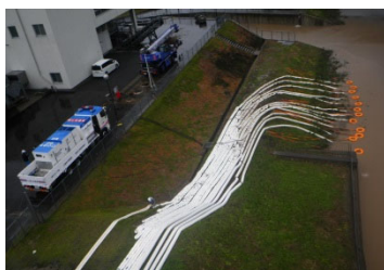
排水ポンプ車 (平成29年10月 台風21号)
