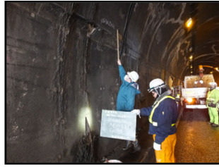
トンネル点検
