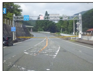
遮断機による道路通行止め
