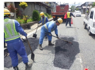
凹凸補修(パッチング)
