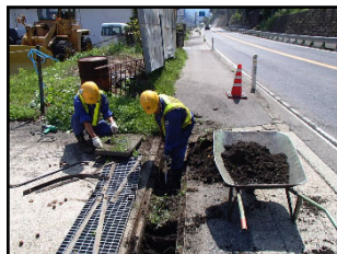
排水構造物清掃
