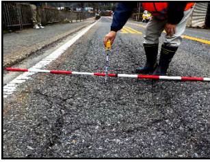
舗装（路面）点検
