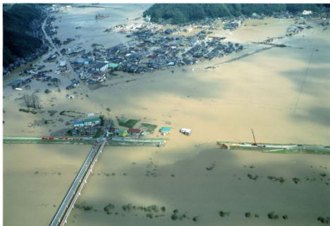
円山川決壊地点の状況（平成 16 年 10 月 21 日撮影） （河口から 13.2km）
