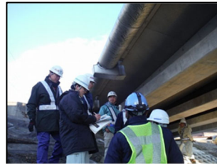
豊岡市道 百合地橋にて橋梁点検実施
