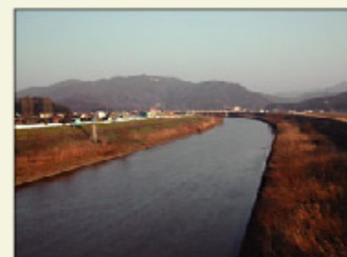
直線化した河道(出石川)
