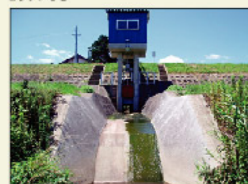
樋門による支川・水路との分断
