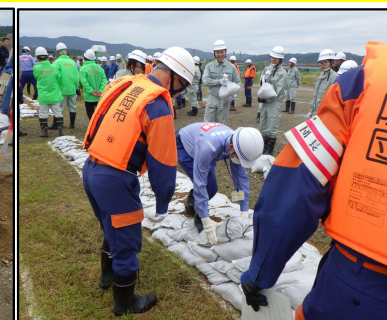
土のう袋を積み上げる
