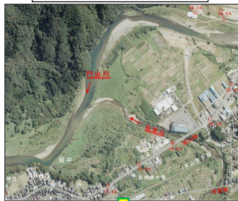
稲葉川合流点処理箇所 整備前
