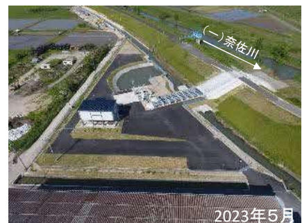
山田川流域内水対策事業 福田排水機場整備
