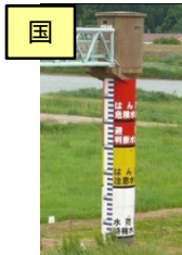
量水標(立野水位観測所)
