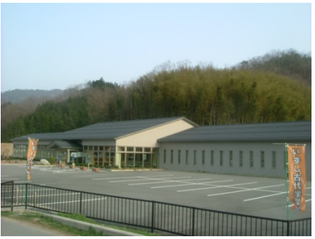
出石川防災センター
