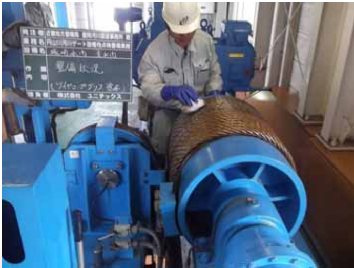
施設の点検(城崎水門)
