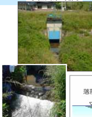
奈佐川第3樋門
