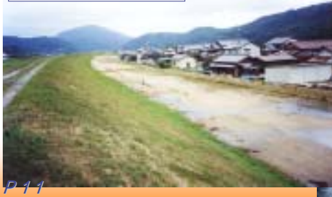
施工前の田鶴野地区
