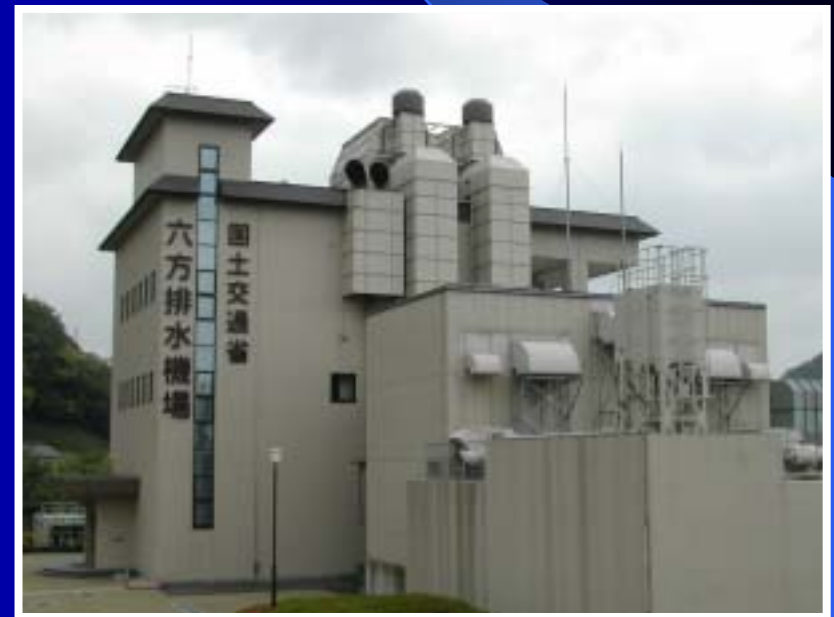
六方排水機場 (平成13年完成)
