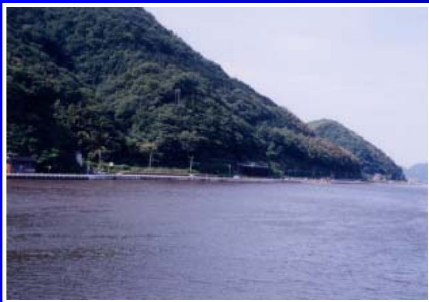
左岸側無堤地区
