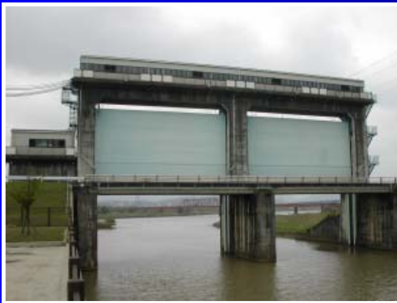
六方水門 (昭和52年完成)
