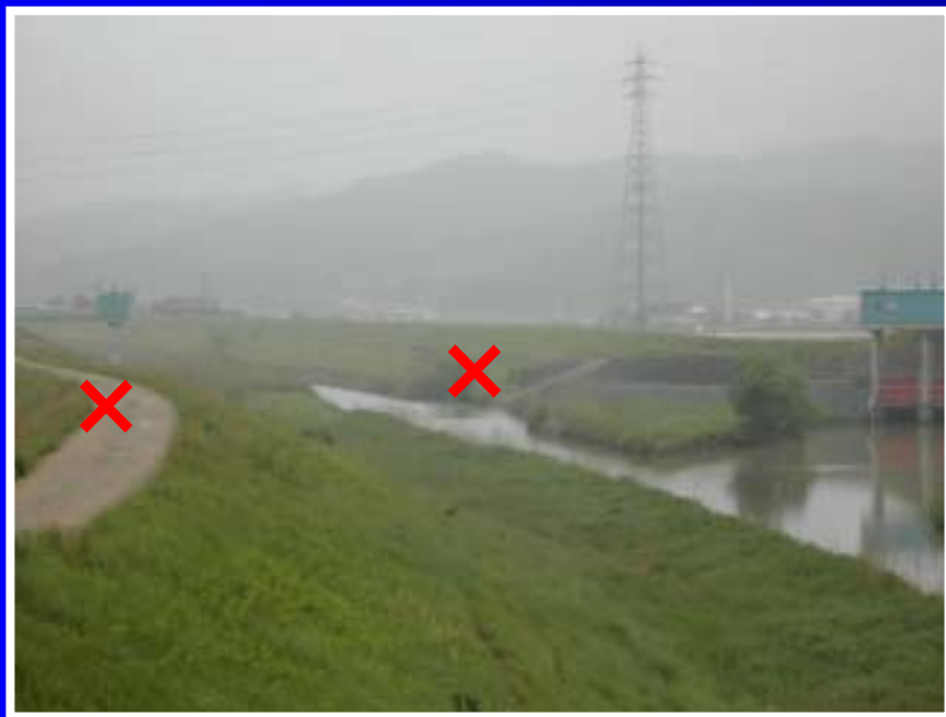
森津橋より上流を望む
